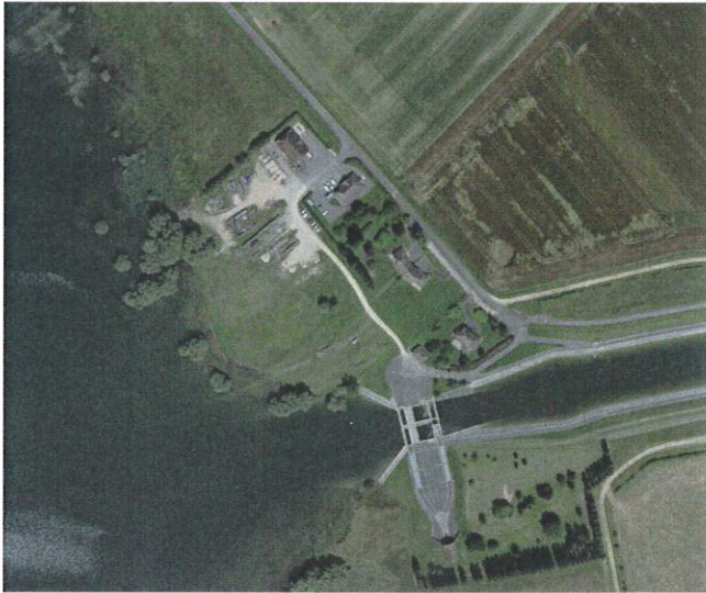
Illustration 8 : Vue aérienne du site
