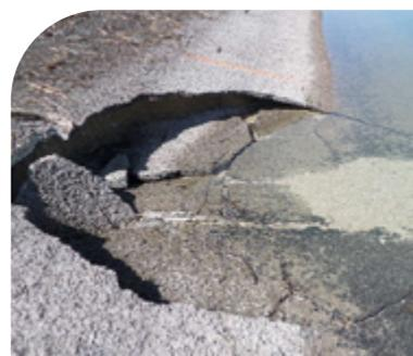
Constat de dégradation de la protection anti-batillage du parement amont – Barrage de la Morge (Seine).
