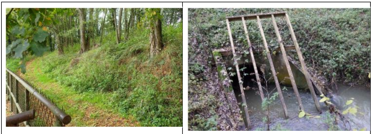
Figure 3-4 : Vue du remblai de l'aménagement hydraulique et de l'ouvrage de rétablissement de la Sinotte (source : BIEF-Cariçaie)
