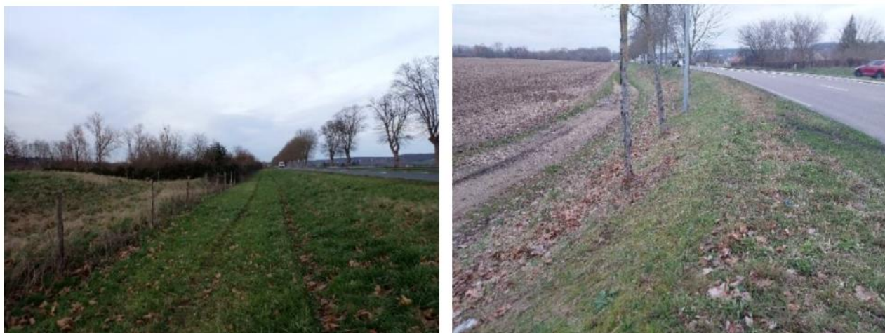
Figure 3-13 : Vues du remblai routier composant le potentiel système d'endiguement de Véron (source : ISL)
