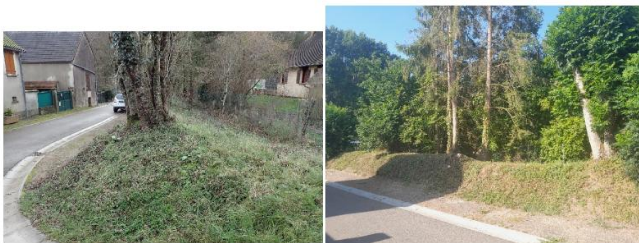
Figure 3-8 : Vues de la digue en terre (source : BIEF-Cariçaie)
