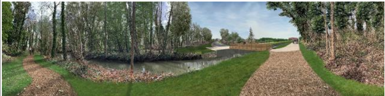
Figure 13 : vue générale du contexte de la digue de liaison et de la passerelle après travaux
