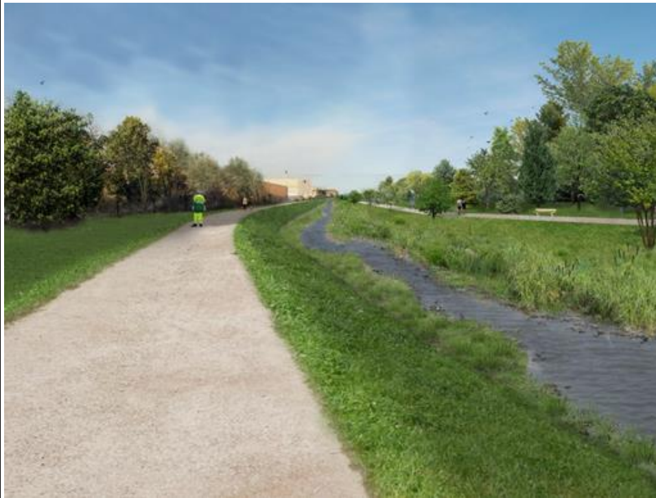
Figure 4 : aspect général du canal de la Papèterie en aval du seuil déplacé après travaux
