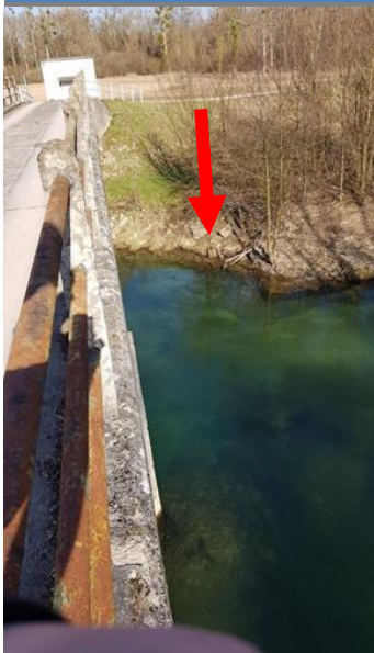
Emplacement de la nouvelle station
