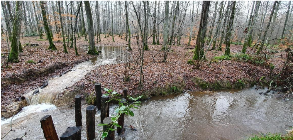
8 Restauration du ru de Vérien - reconnexion de méandre par installation de pieux favorisant le ralentissement des écoulements dans le lit actuel et la reprise progressive des écoulements dans le méandre
