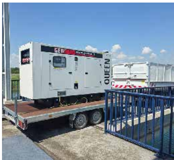
Mobilisation d'un groupe électrogène mobile
