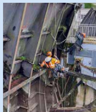
Inspection par cordistes de la vanne de réglage – passe gauche
