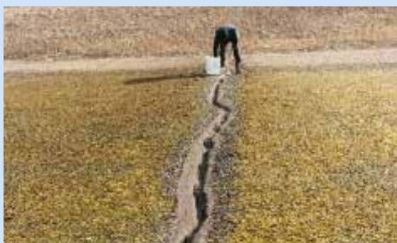
Entretien des fossés bétonnés et réparation de fissures
