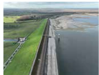
Digue de la Morge vue du ciel
