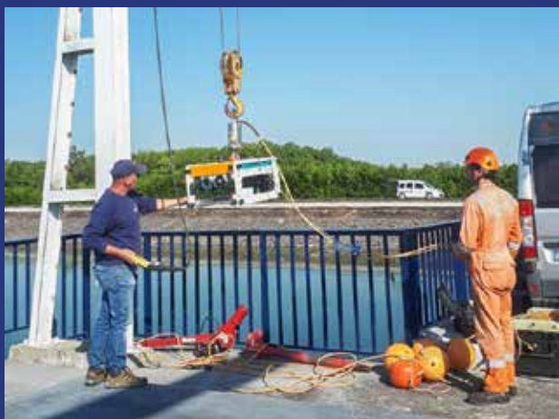
Mise à l'eau du robot d'inspection subaquatique
