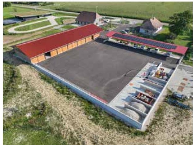
Réhabilitation du lieu d'appel de Mathaux
