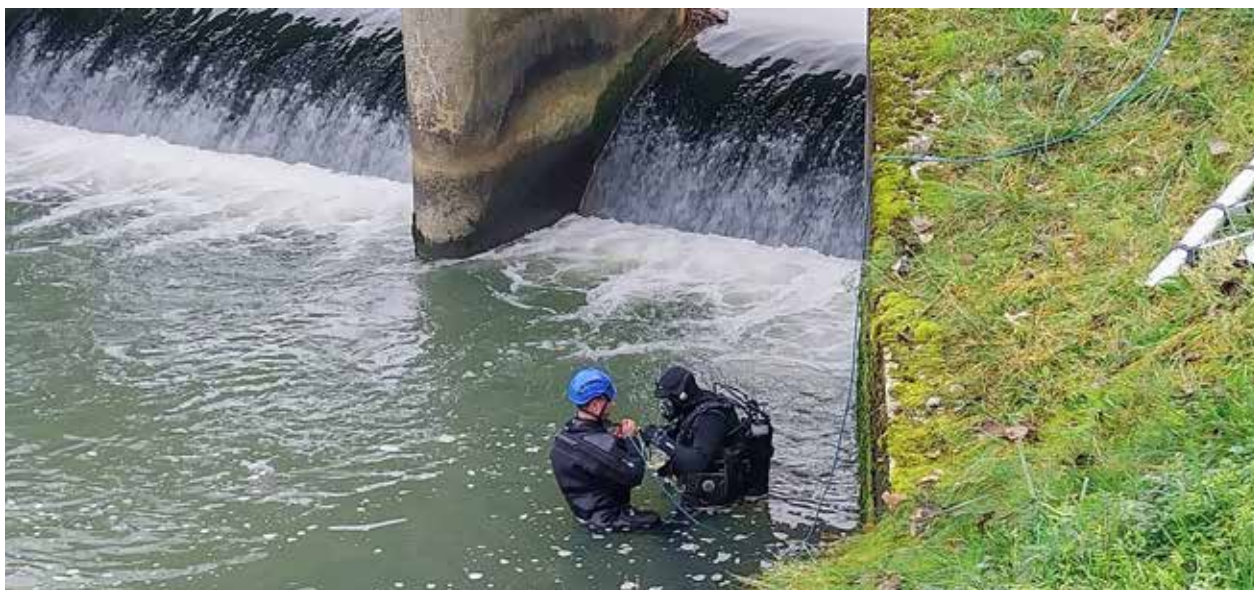
Intervention de plongeurs pour le diagnostic subaquatique d'un pont sur le canal de restitution Seine
