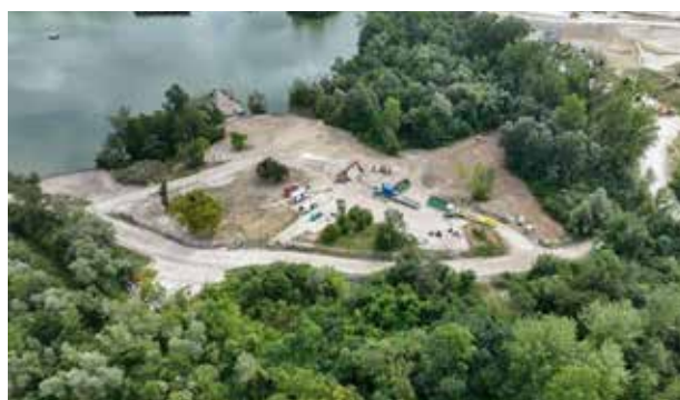
Darse : travaux de démolition achevés (septembre 2024)
