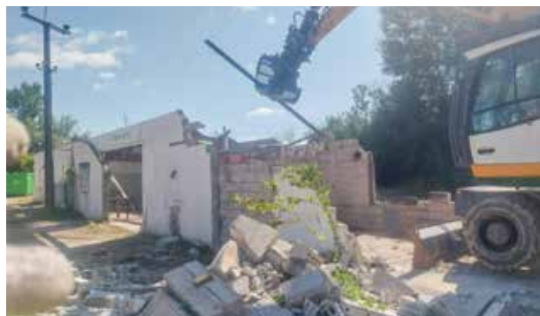
Travaux de curage, désamiantage, déconstruction des anciennes installations de la société LMPS Juillet-août 2024 (société PAPREC – MOE AD INGé-EGIS)
