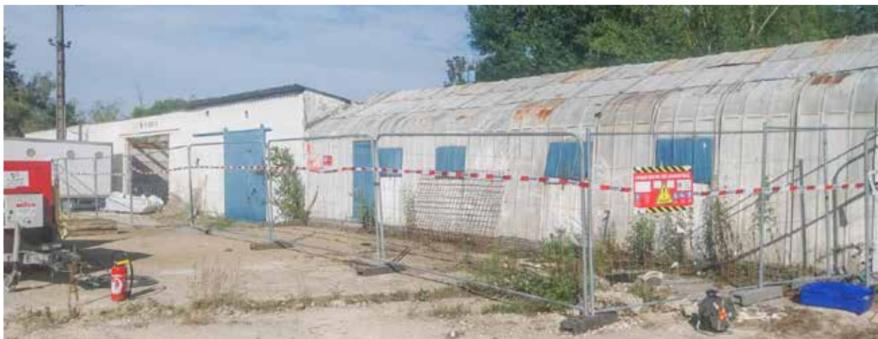
Anciens bâtiments société LMPS avant leur démolition – juin 2024
