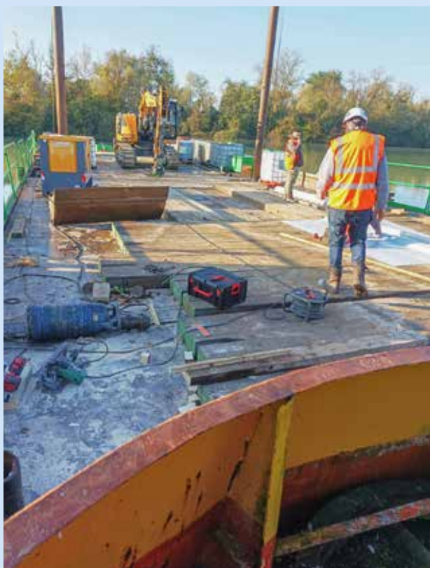
En complément des barrages anti-pollution : pompage et sécurisation des cales afin d'éviter toute pollution aux hydrocarbures. (Société PAPREC – MOE AD INGé-EGIS)
