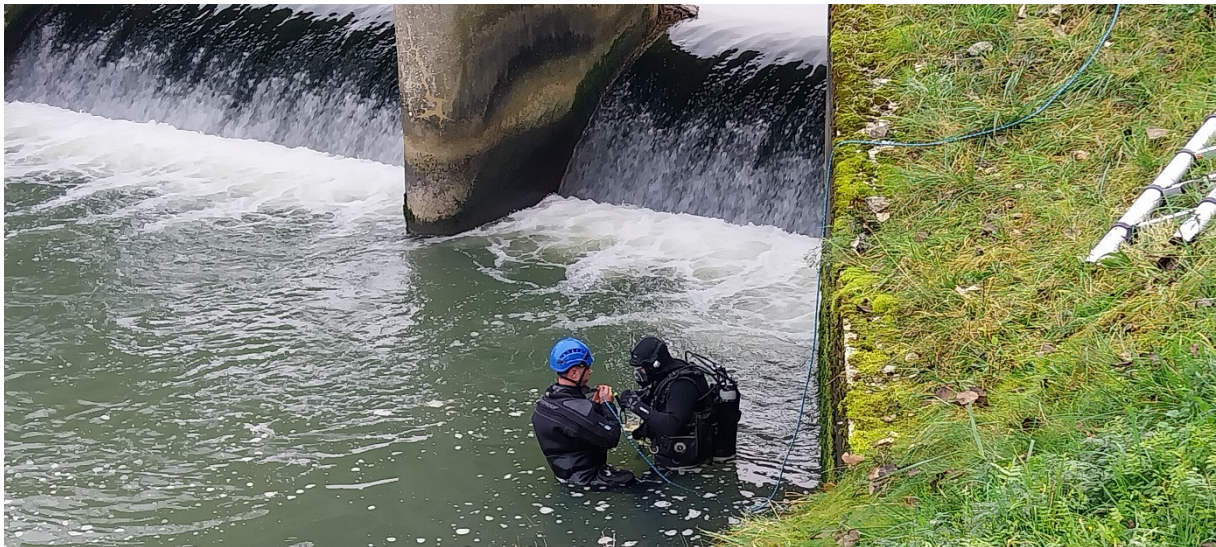
Intervention de plongeurs pour le diagnostic subaquatique d'un pont sur le canal de restitution Seine
