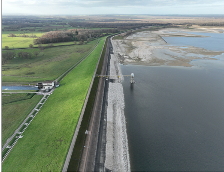
Digue de la Morge vue du ciel
