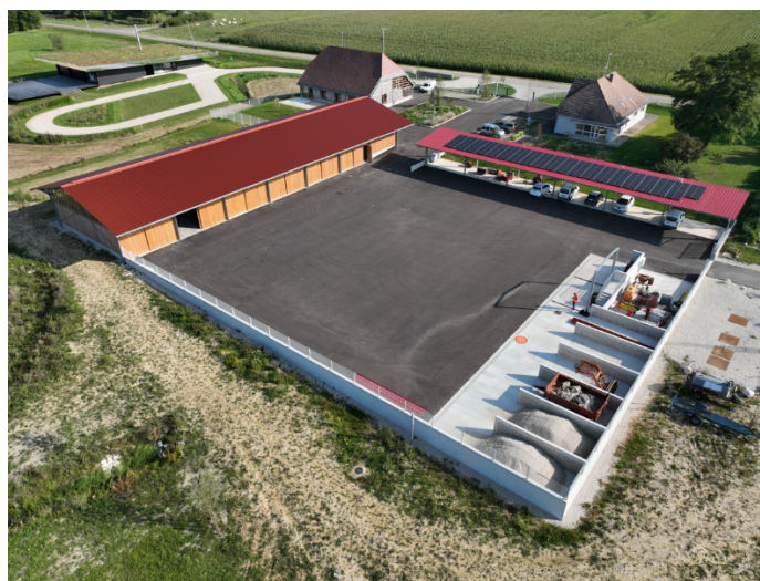
Réhabilitation du lieu d'appel de Mathaux
