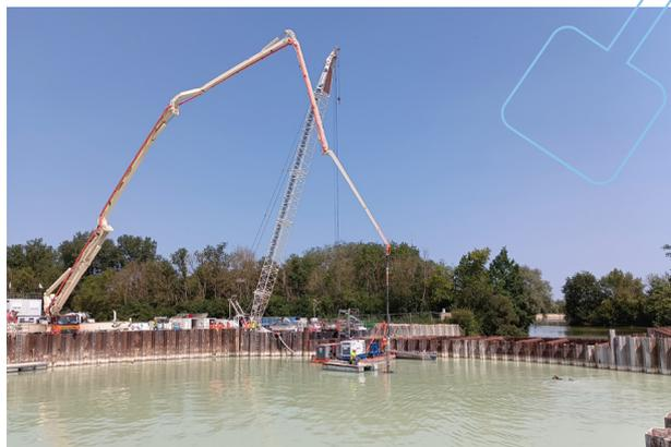
Coulage du béton immergé, préalablement à la réalisation du radier de la station principale
