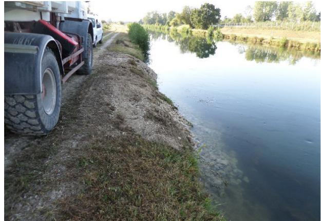
Confortement réalisé avec des enrochements afin de stabiliser la berge du canal de restitution Seine
