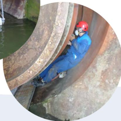
◀ **NETTOYAGE DE LA PARTIE FIXE (DÉPÔT DE ROUILLE, RÉSIDUS DE L'ANCIEN JOINT), PUIS REMPLACEMENT PAR UN JOINT NEUF**
