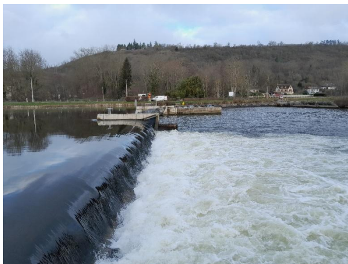
Figure 41 : Barrage de Vaux (89) reconstruit (VNF)
