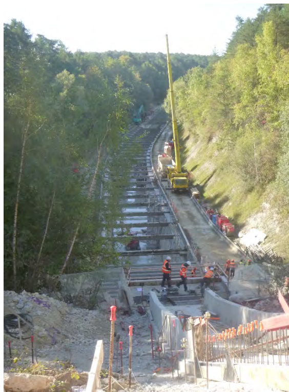
Photo 1 : Travaux sur le canal d'amenée (28/09/2018)
